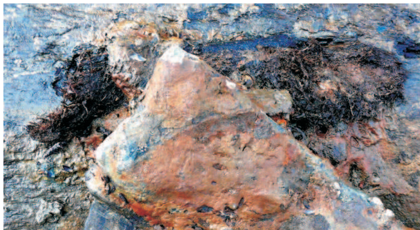
Ryc. 5. Zbliżenie na fragment metalowego okucia na belce zewnętrznej z częściowo zachowaną uszczelką wykonaną z mchu, fot. A. Ostasz Fig. 5. Close-up of a piece of metal mount on the external beam with a partially preserved gasket made of moss, photo A. Ostasz
