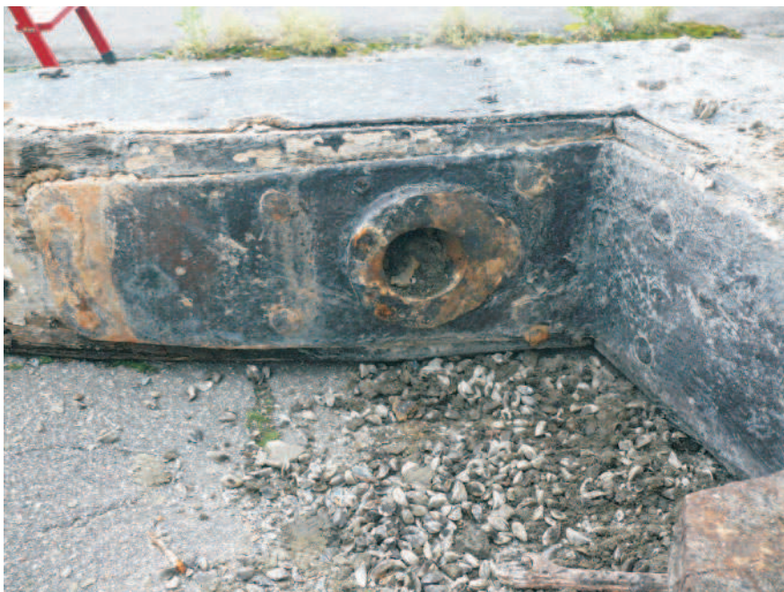
Ryc. 2. Widok na otwór mocujący na sterownicy od strony dolnego okucia, fot. A. Ostasz Fig. 2. A view of the fixing hole from the side of the lower mount, photo A. Ostasz
