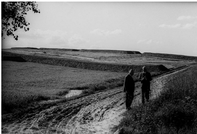
Ryc. 3. Otto Kunkel (z prawej) w trakcie wizytacji budowy R.A.B. w okolicy Brzeźniaka, pow. łobeski, 9 VI 1939 r. W tle widoczny odhumusowany korpus autostrady. Archiwum DA MNS, negatyw nr F51.12
